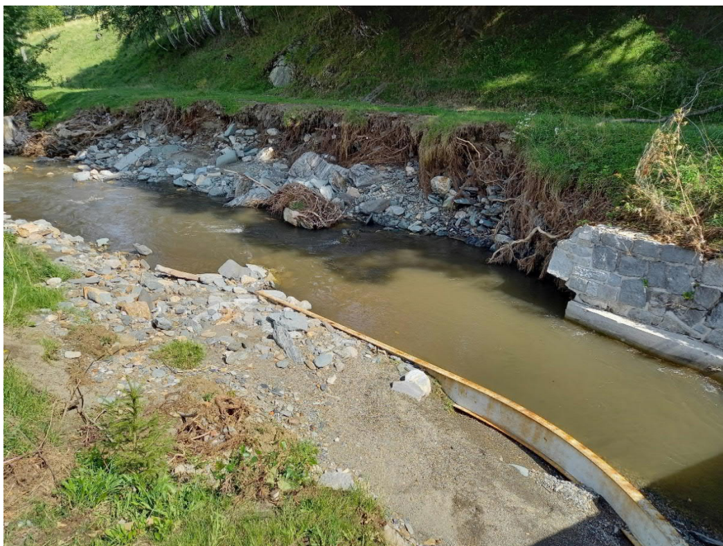
Obr. 20: Rozebrané opevnění (kamenná dlažba do pískového lože) a vzniklá nátrž na PB v km 27,485-27,505
