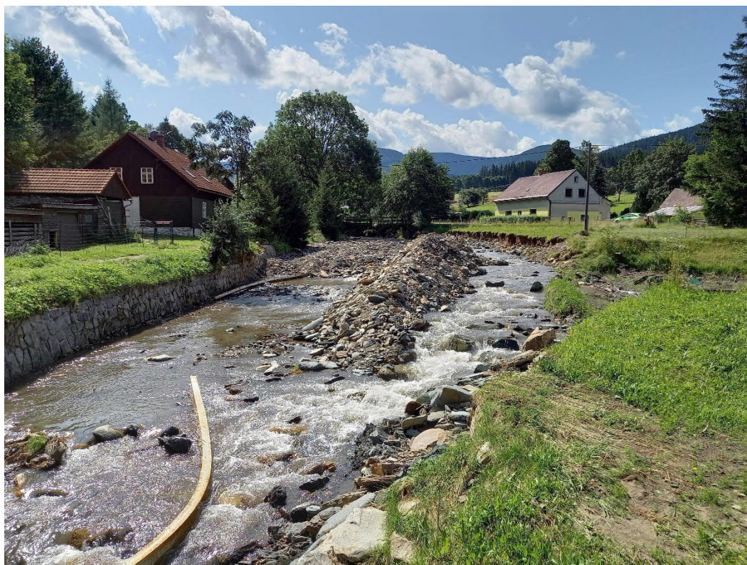
Obr. 21: Rozebrané opevnění včetně mostního pilíře a vzniklá nátrž na LB v km 27,505-27,639
