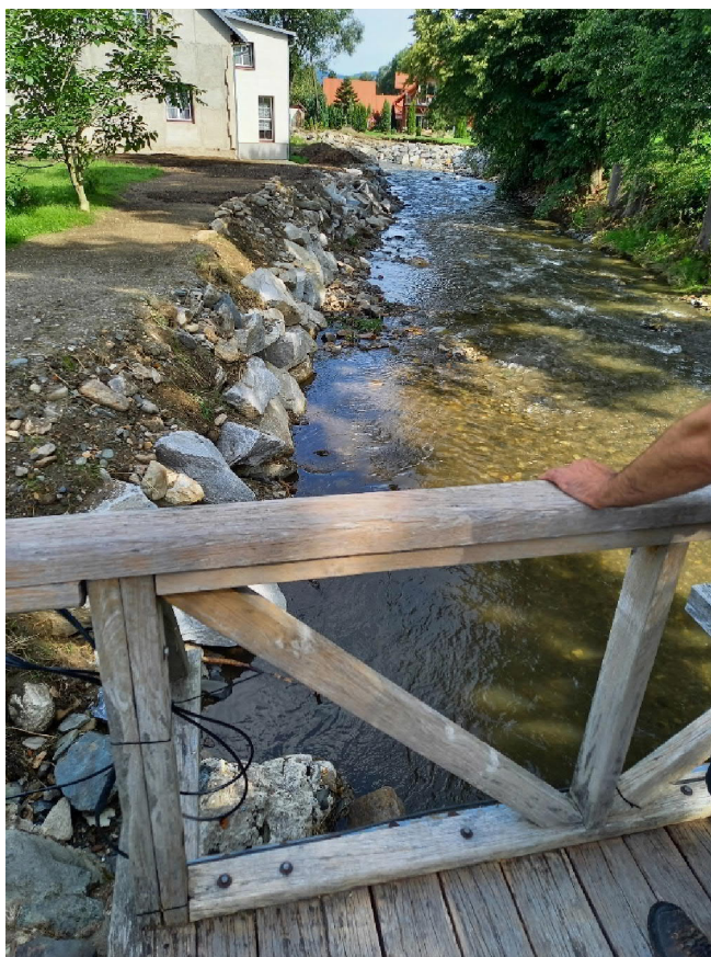
Obr. 13: Provizorně zabezpečená nátrž na LB v km 26,512 až 26,670
