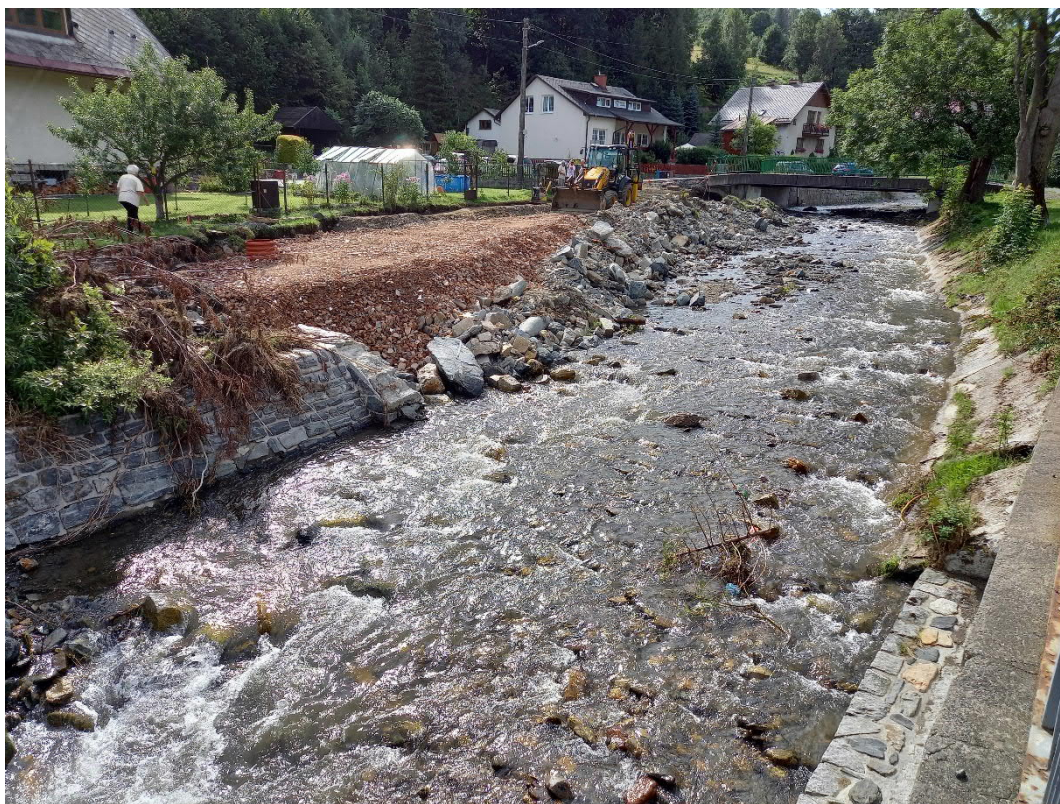
Obr. 6: Provizorní zabezpečení nátrže na PB v km 26,101 až 26,150
