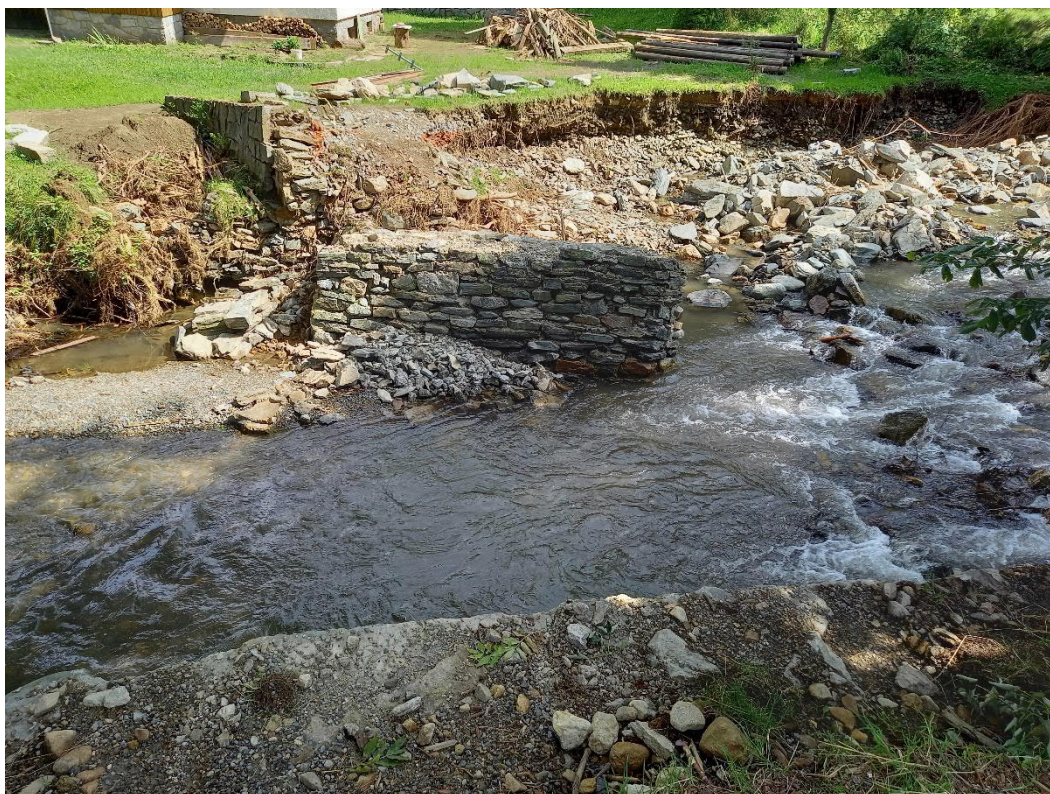
Obr. 22: Rozebrané opevnění včetně destruovaného mostního pilíře a vzniklá nátrž na PB v km 27,639-27,690
