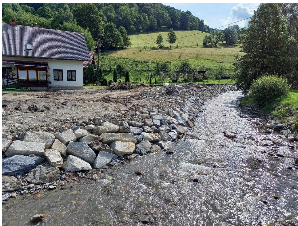
Obr. 12: Provizorně zabezpečená nátrž na PB v km 26,512 až 26,670
