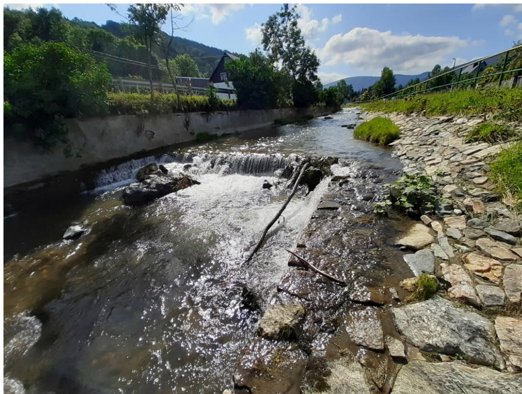
Obr. 4: Příklad poškozeného balvanitého skluzu mezi lávkou v km 25,614 (25,634 dle TPE) a silničním mostem v km 25,912 (25,910 dle TPE)
