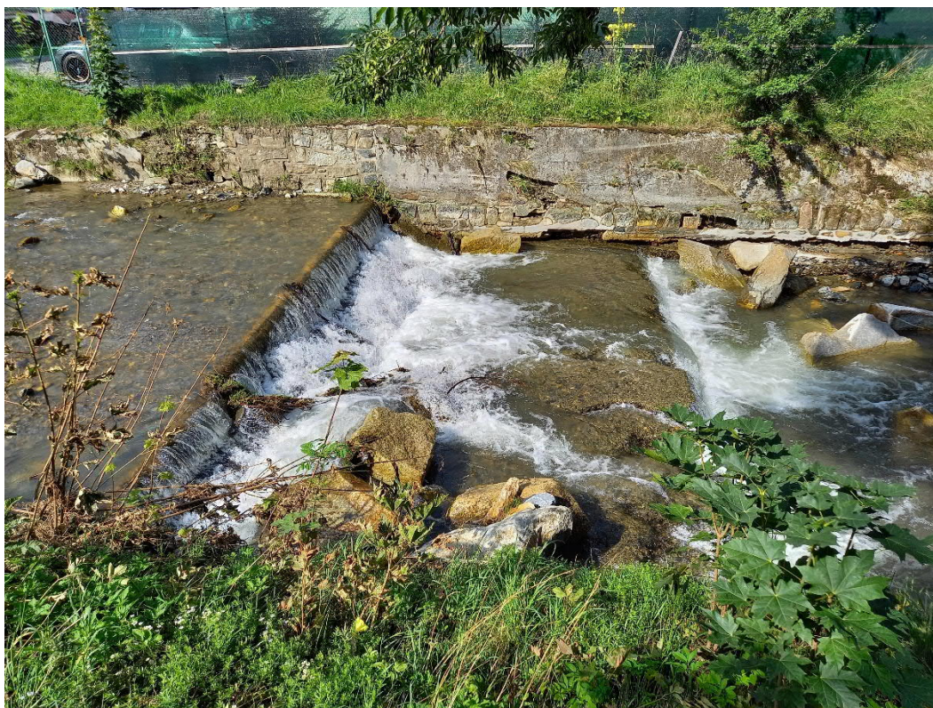
Obr. 9: Poškozený stupeň včetně nábrežních zdí v km cca 26,354
