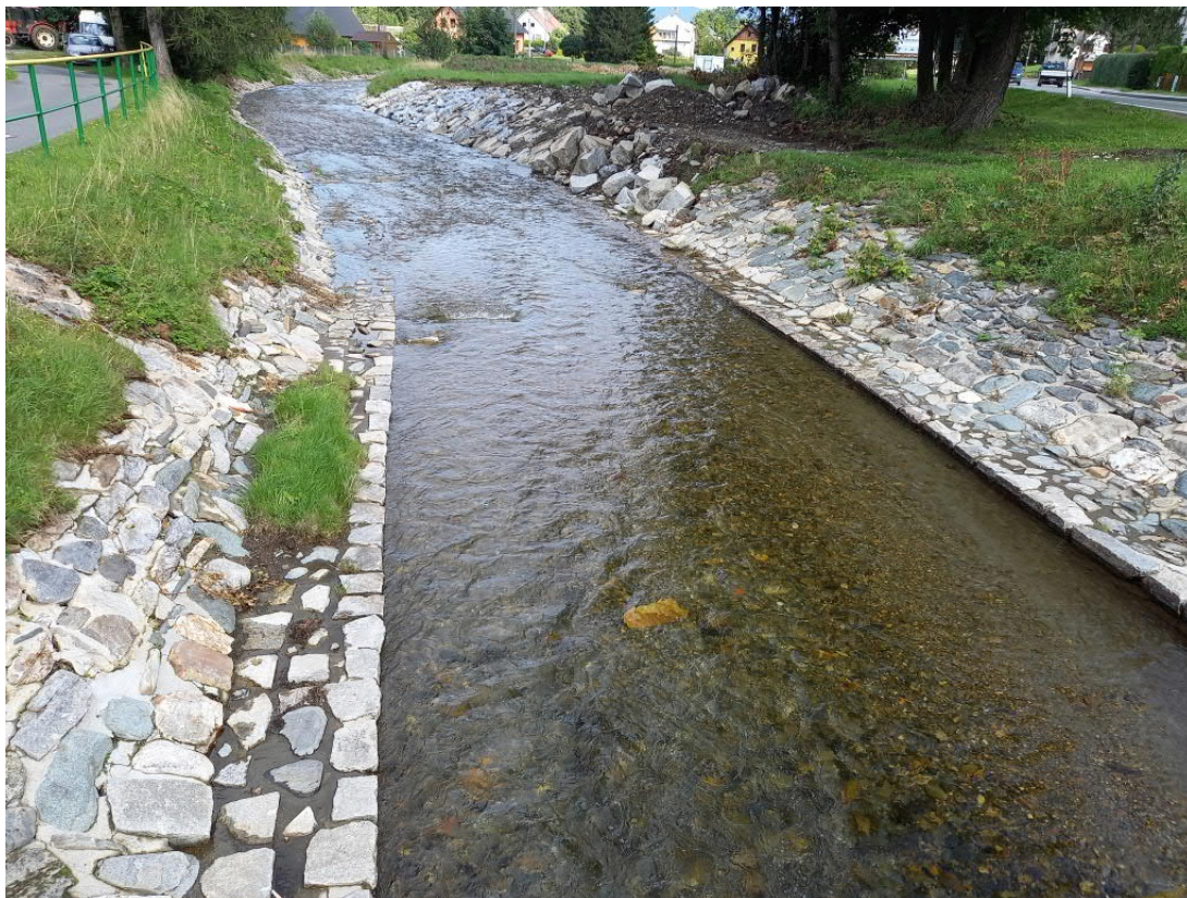
Obr. 2: Koryto Bělé nad zaústěním Filipovického potoku – rozebrané opevnění na PB
