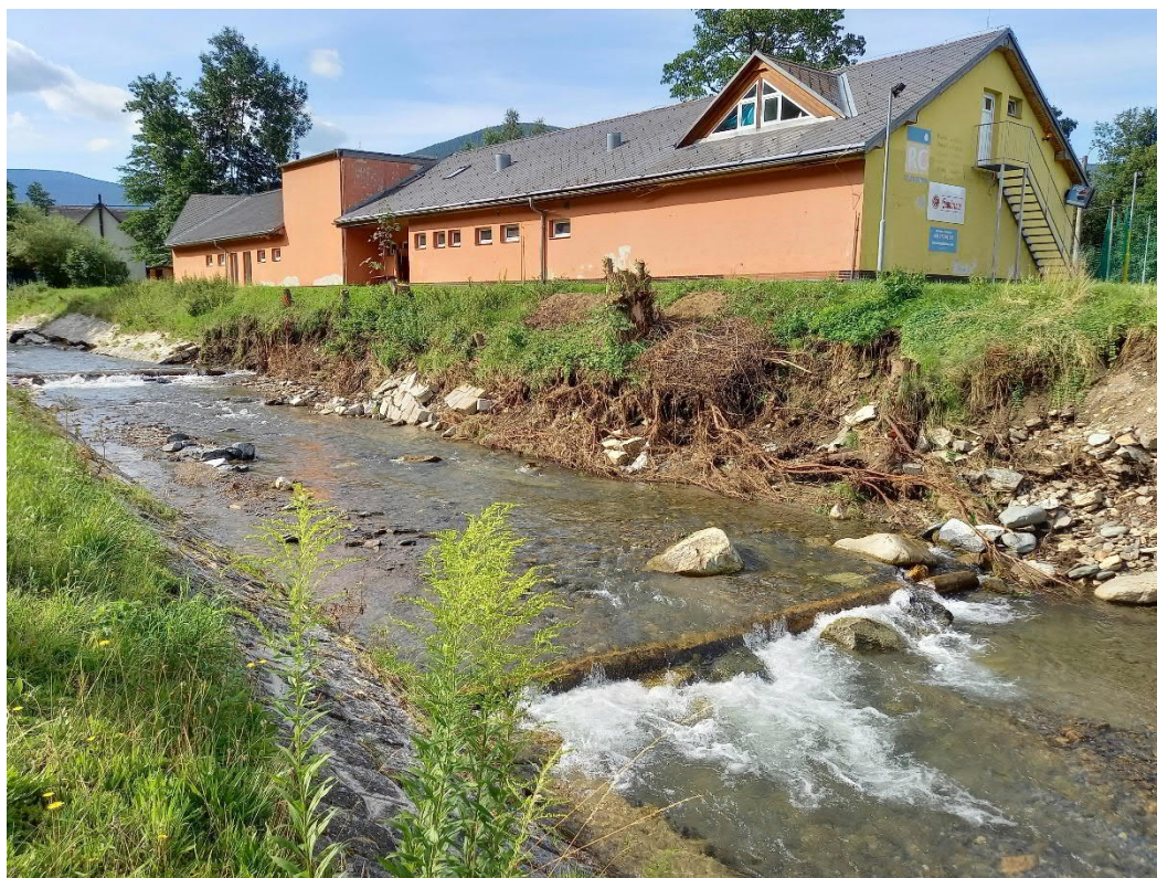
Obr. 8: Nátrž na LB v místě opevnění kam. dlažbou do písčového lože v km 26,225-26,357
