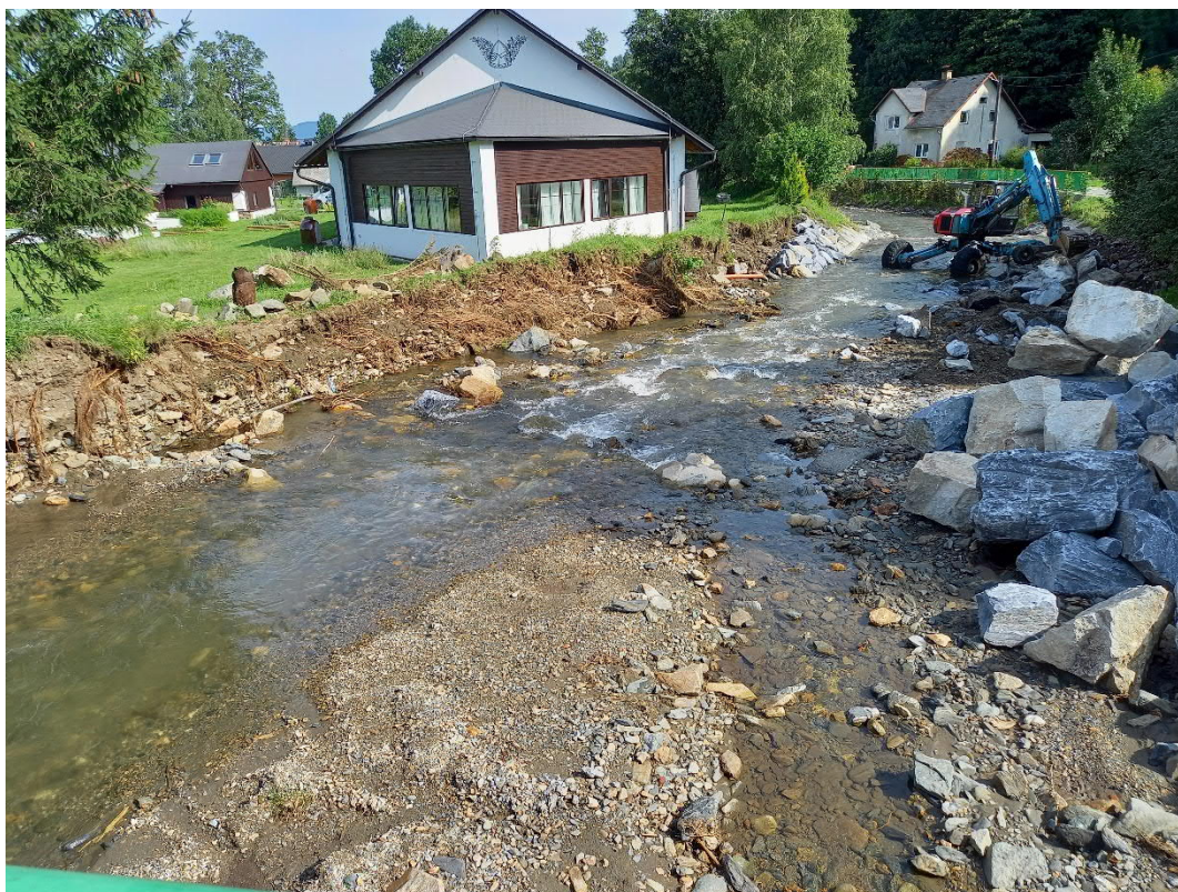
Obr. 10: Poškozené opevnění (kamenná dlažba do pískového lože) na obou březích v km 26,424 až 26,465
