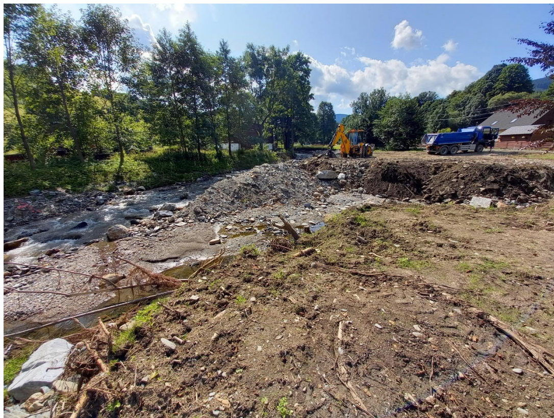
Obr. 18: Provizorní zabezpečovací práce na nátrži na LB v km 27,205 až 27,270
