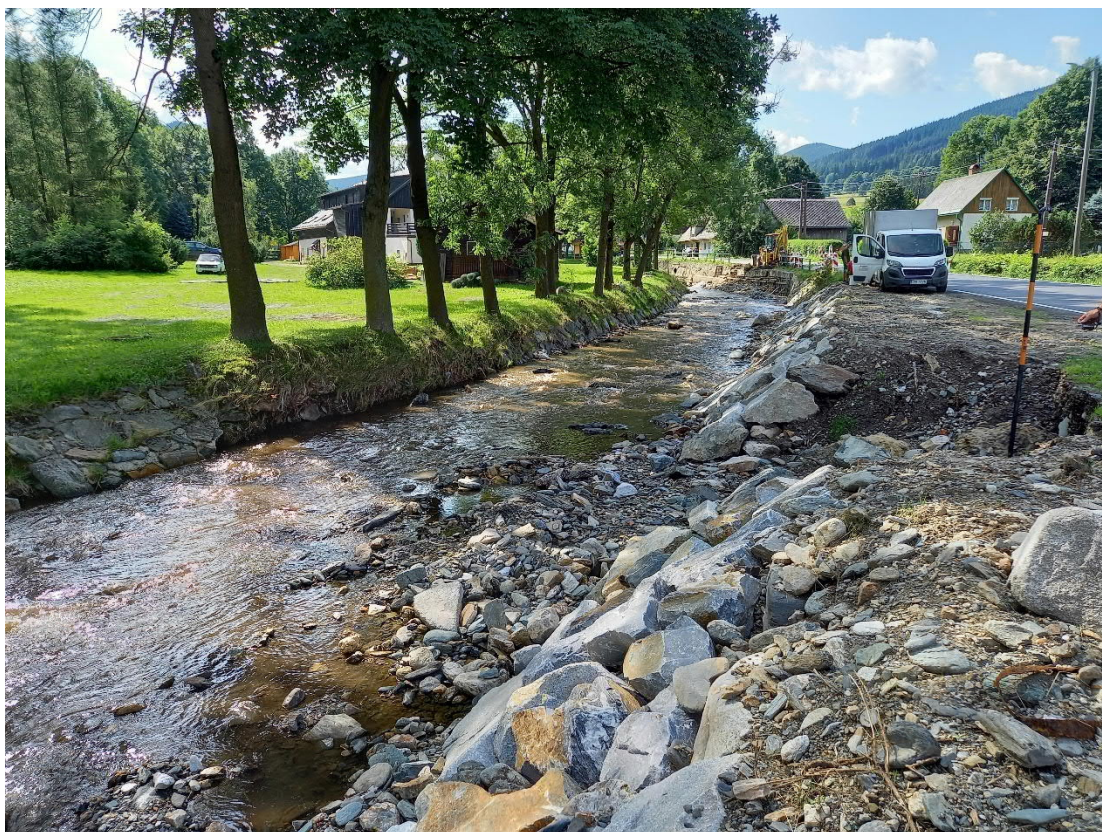
Obr. 15: Provizorně zabezpečená nátrž na LB v km 26,905 až 27,038
