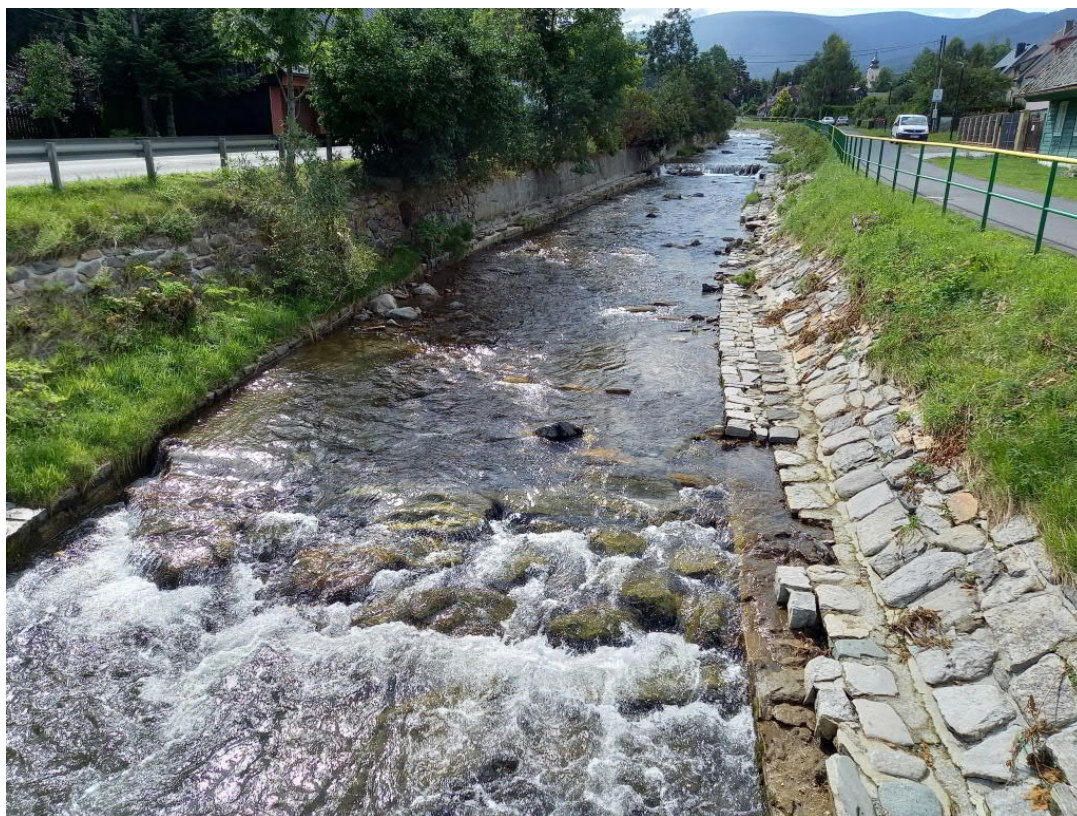
Obr. 3: Koryto Bělé nad lávkou v km 25,614 (25,634 dle TPE) – oderodovaná patka
