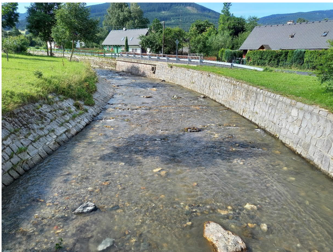
Obr. 11: Nepoškozený úsek opevnění v km 26,465 až 26,512
