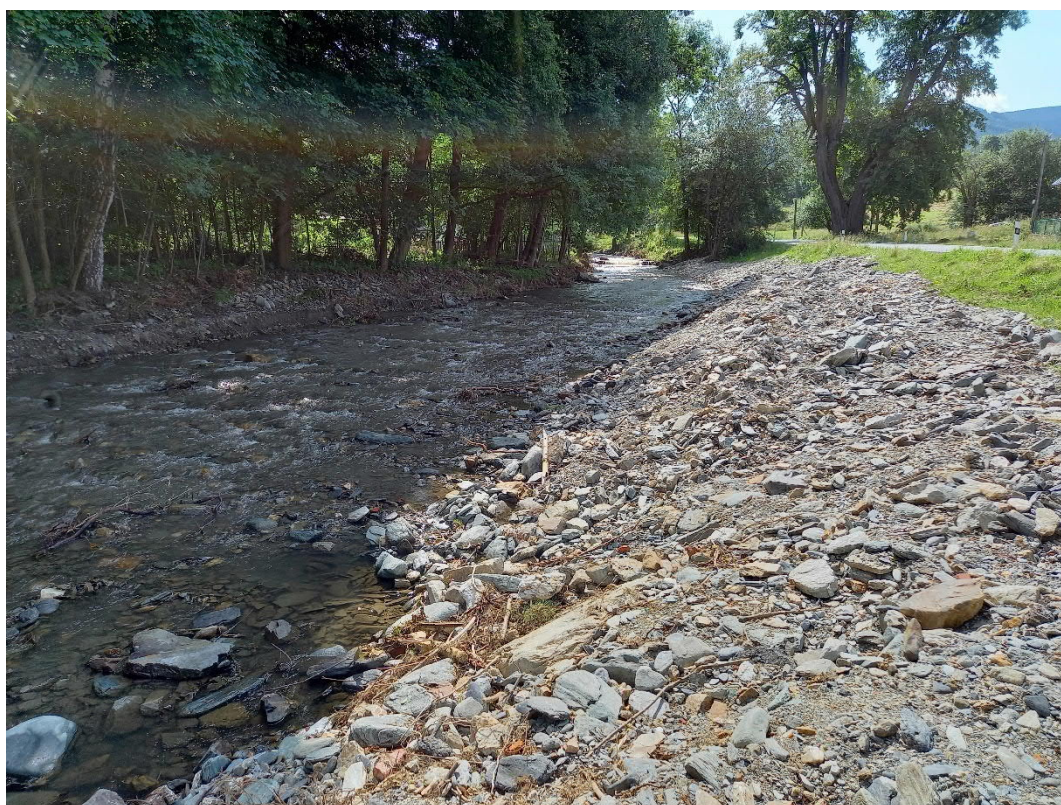
Obr. 23: Provizorně zabezpečená nátrž na LB v km 27,690 až 27,800
