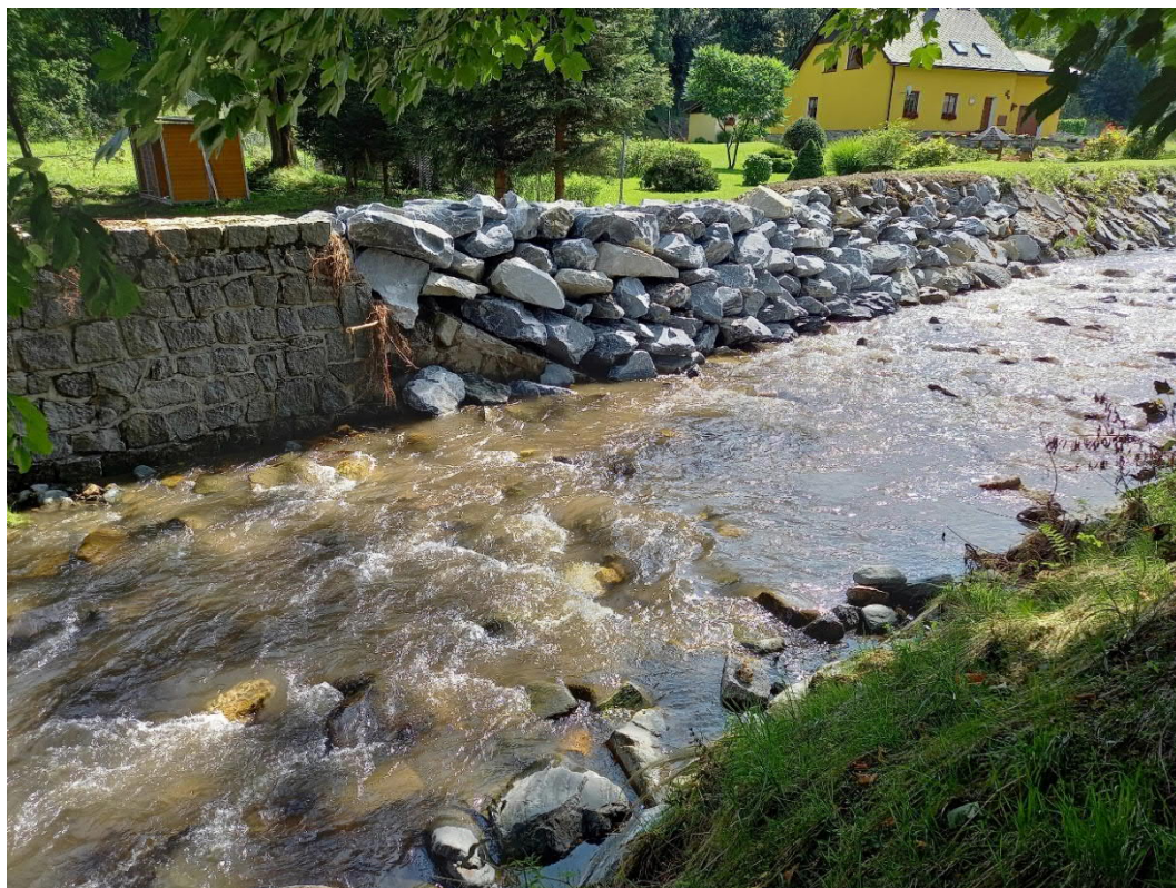
Obr. 16: Rozebrané opevnění na PB – nábrežní zeď a kamenná rovinanina – km 27,038 až 27,149
