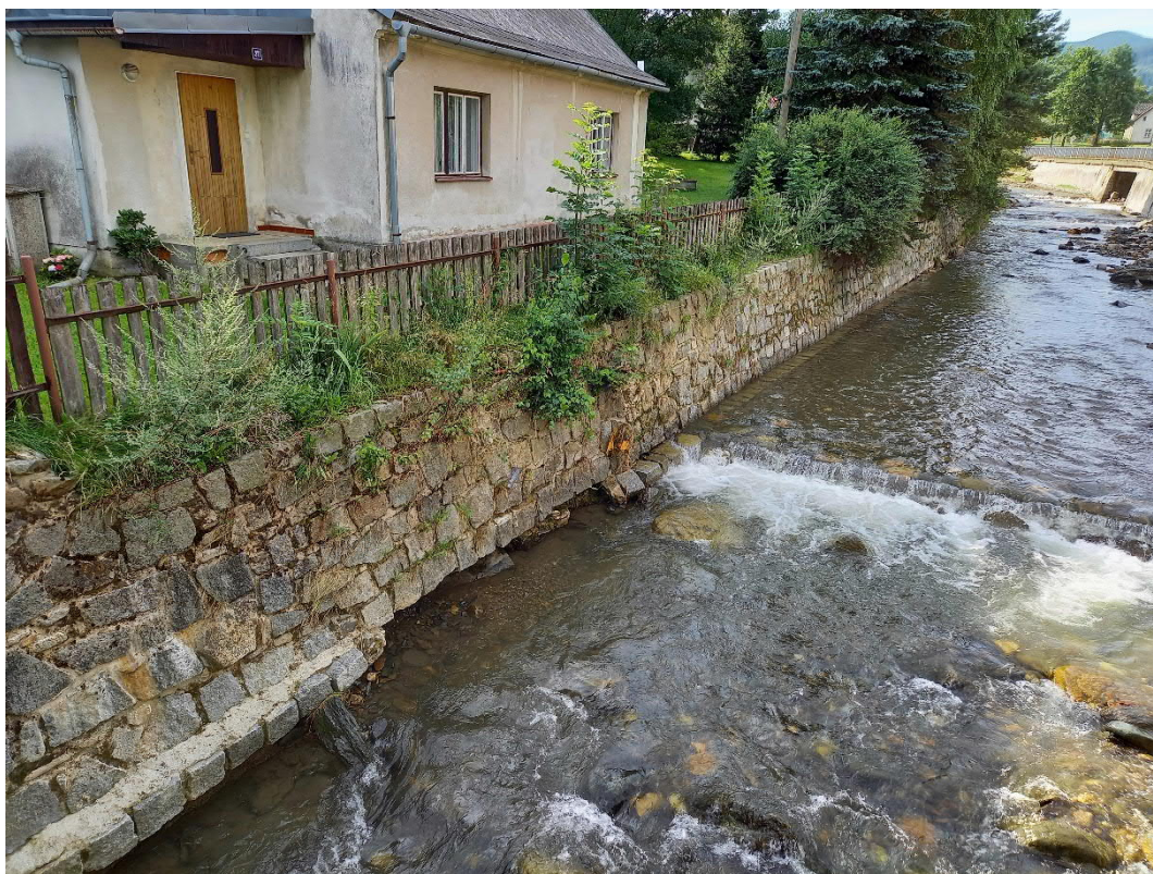
Obr. 5: Porušené spáry a odebrané patky stávajících nábrežních zdí v km 25,912 až 26,101
